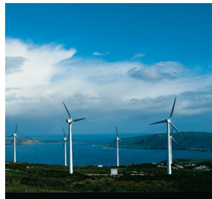
Energia eolikoko zentrala.
