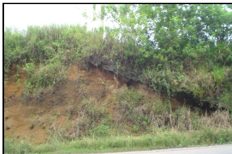
Ilustración 3.6 : Contacto entre la formación Avalancha Ardiente (color oscuro con el piso inclinado hacia la esquina inferior derecha de la fotografía) y la formación Pacacua (materiales marrón junto a la carretera). Octubre – 2005
