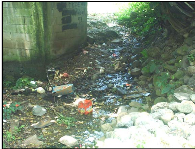
Ilustración 3.10. Parte del Cauze del Río Uruca cerca de Salitral, cargado con desechos sólidos y aguas servidas provenientes de las viviendas próximas al río. 02 – octubre - 2005
