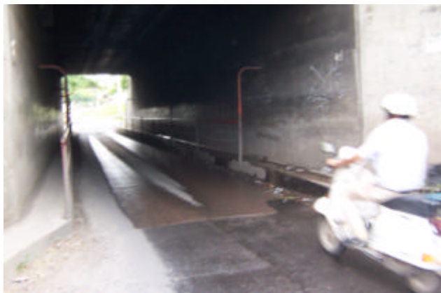
Fotografía 3. Puente bajo ruta 27, sobre la calle vieja a Pozos
