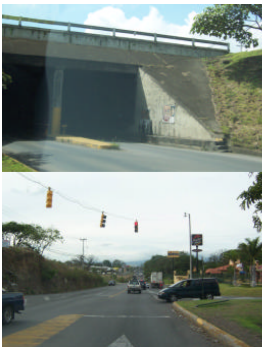
Fotografía 6. Puente de cruce entre las rutas 27 y 147. Semáforos a la salida del mismo
