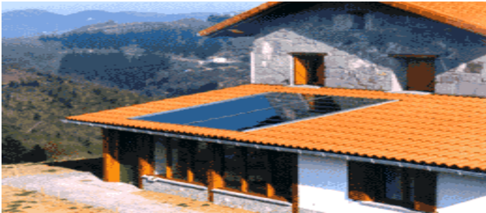
Figura 3. Sistema de Aquecimento Solar de Água já instalado.
