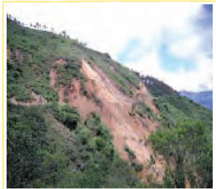
Deslizamiento de tierra zona del Sural – Ayabaca.
