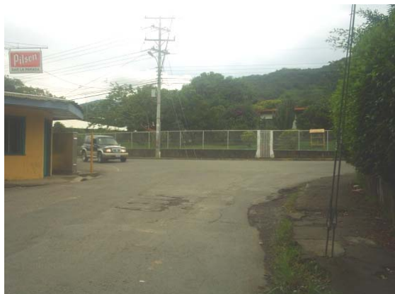
Ilustración 5.74. Falta de Señalización Vial
