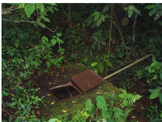
Ilustración 5.11 Tanque Acueducto Montoya
