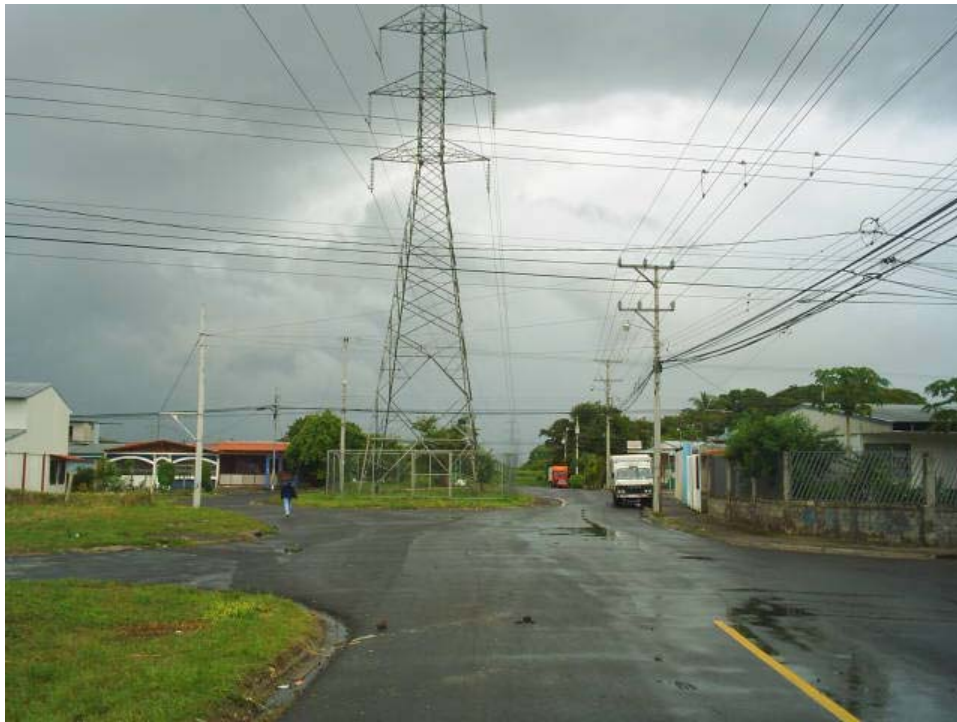
Ilustración 5.27. Torre y Líneas de Transmisión Eléctrica en Lagos de Lindora
