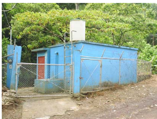
Ilustración 5.3. Tanque de Almacenamiento
