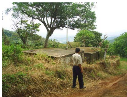
Ilustración 5.12 Tanque Acueducto Montoya
