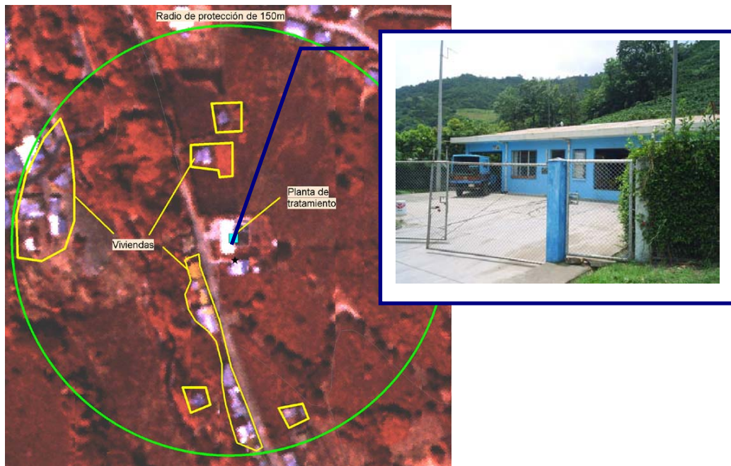
Ilustración 5.5. Planta de tratamiento de Salitral Ilustración 5.6. Planta de tratamiento del AyA en Salitral
