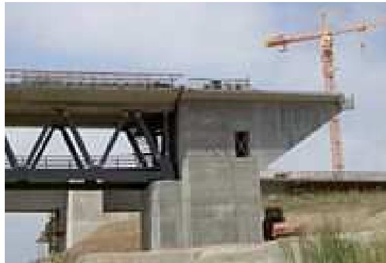
Estribos de un puente en construcción.
